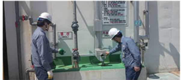
유해화학물질 설비 점검
